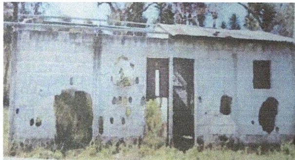
Foto: Reparacion y sustitucion de area de cocina (incluye reparacion de pares, estufas rurales, pilas, ventanas, puertas, chimenea, etc.)
