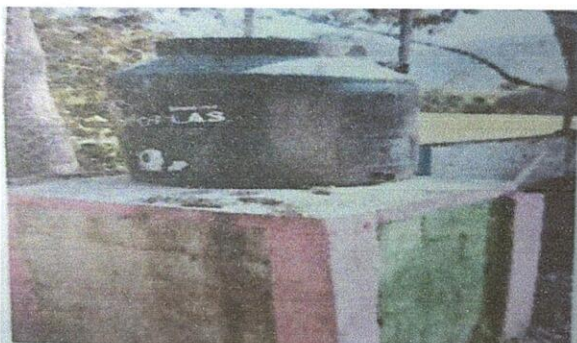
Foto 3: suministro e instalación de torre metalica para deposito de agua y suministro e instalacion de deposito de agua.
