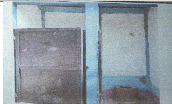
Foto 2: cambioe instalacion de inodoros(incluye accesorios)
