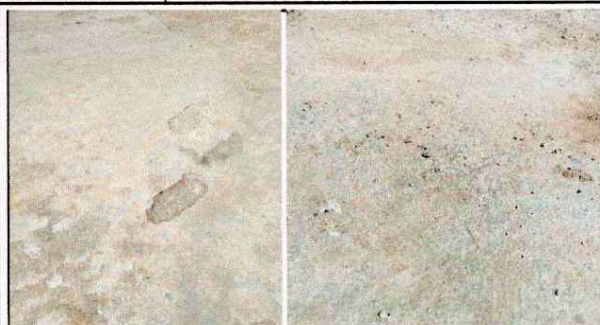
Foto1: Reparación de losa de patio. (Renglón 1)
