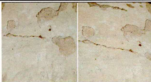
Foto 2: Reparación de losa de patio. (Renglón 1)
