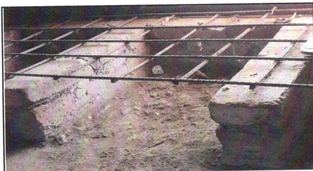
Foto 3: SE NECESITA SUSTITUCION DE ESTUFA RURAL EN AREA DE COCINA
