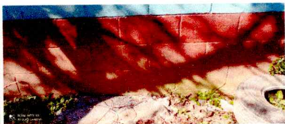
Foto 1: Reparación de pared por filtración de agua cubriendo 8 metros lineales de repello cernido por 1 de alto
