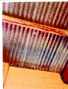
Foto 4: Sustitución de lamina
