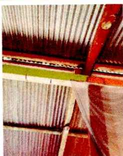
Foto 3: Sustitución de estructura de techo
