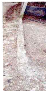
Foto 2: Sustitución de muro perimetral
