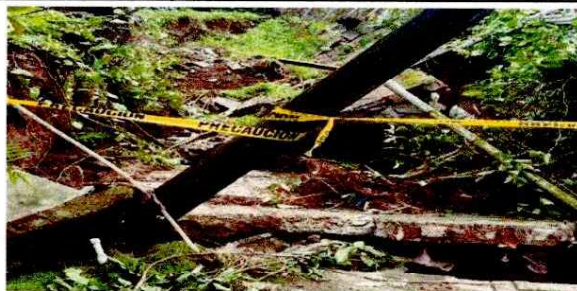
Foto 6: En esta fotografía se puede observar la necesidad que existe de reparar el muro perimetral
