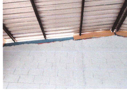
Foto 8 : CUBIERTA DE LAMINA
