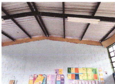
Foto1: REPARACION DE SISTEMA ELECTRICO
