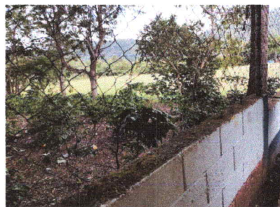
Foto 4: CERCO O MURO PERIMETRAL
