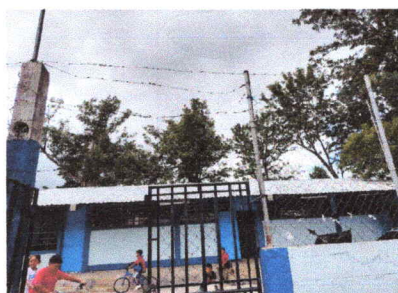
FOTO 6: MANTENIMIENTO A PORTONES
