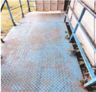
Foto 7: MANTENIMIENTO DE BARANDAS
