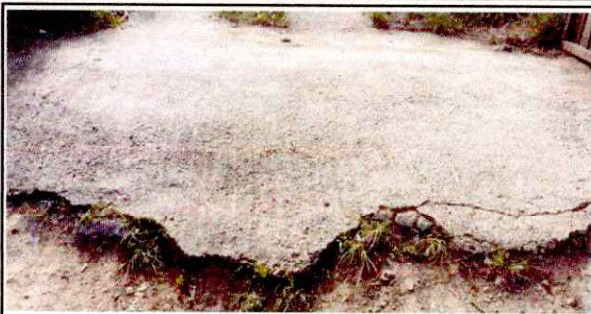
Foto 1: LOSA DE PATIO
