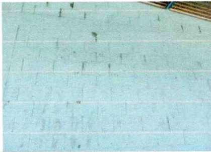
Foto1: PINTURA EN MUROS INTERIOR Y EXTERIOR
