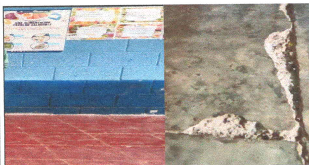
Foto 5: Reparacion o sustitución de azulejo
