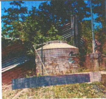
Foto1: Reparación y mantenimiento de cisternas o depósitos de agua.
