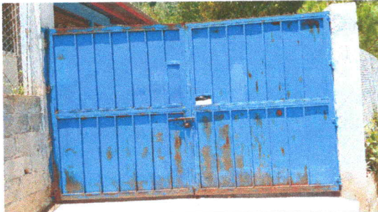
Foto 3: Mantenimiento de portón.
