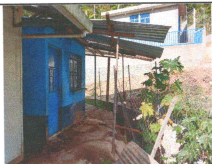
Foto 3: Reparación de techo en area de cocina.
