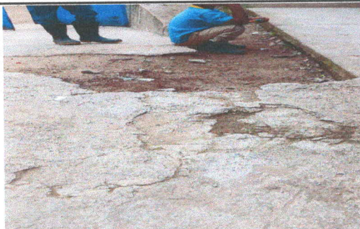
Foto 1: Losa de patio
