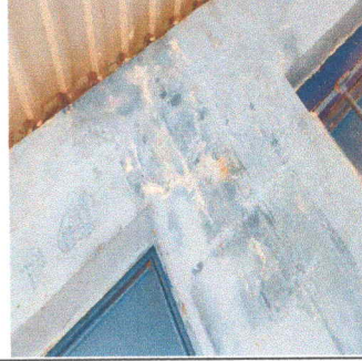
Foto 2: Pintura en muros interior y exterior.
