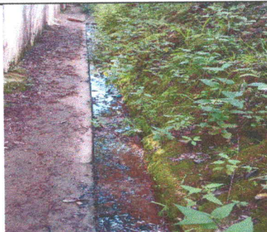
Foto 2: Cuneta de concreto
