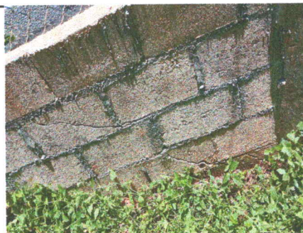
Foto 4: Reparacion de muro Perimetral
