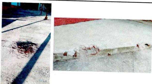
Foto 3: Sustrucción de losa de patio
