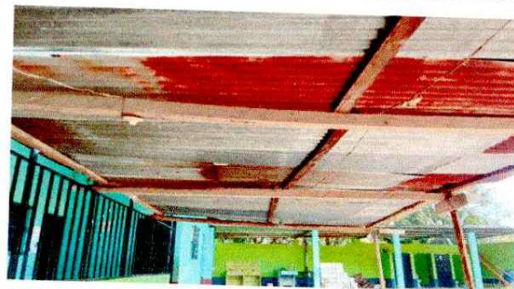
Foto 2: Sustrucción de techado en área de refacciones y eventos de los niños
