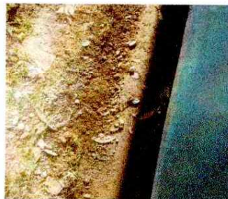
Renglón 2: Reparación de cuneta para captación y circulación de agua de lluvia, canal se encuentra azolvado
