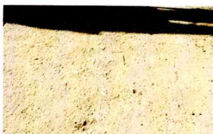
Renglón 5: Sustitución de losa de patio
