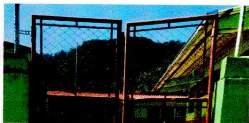
Renglón 3: Sustitución de portón
