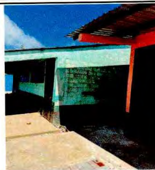
Foto 2: CANALES Y BAJADAS DE AGUA, VISTA LATERAL
