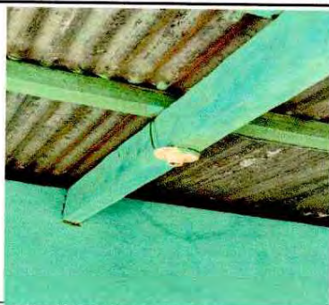
Foto 5: ÁREA DE AULA INTERIOR ELÉCTRICA
