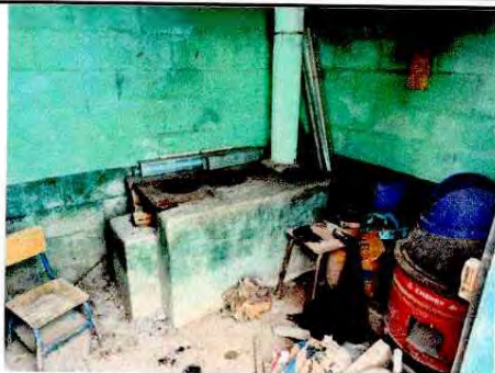
Foto 1: PISO DE GRANITO EN ÁREA DE COCINA
