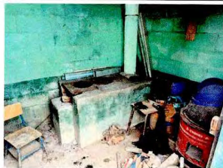
Foto 2: ÁREA DE COCINA INTERIOR
