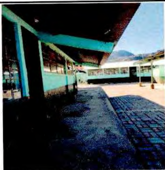
Foto 3: CANALES Y BAJADAS DE AGUA VISTA LATERAL.
