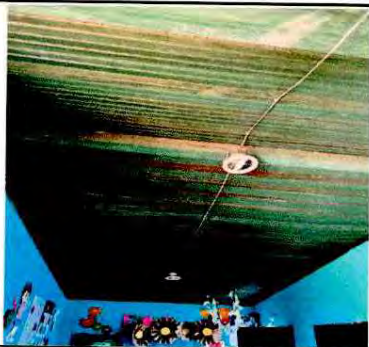
Foto 1: ÁREA ELÉCTRICA DE AULA 1
