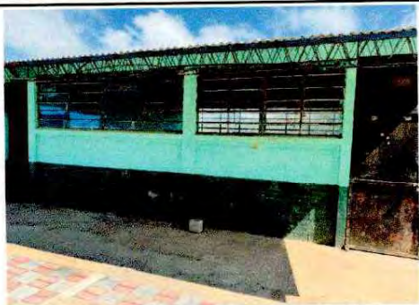
Foto1: CANALES Y BAJADAS DE AGUA, VISTA ANTERIOR
