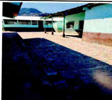
Foto 6: ÁREA ELÉCTRICA DE PATIO
