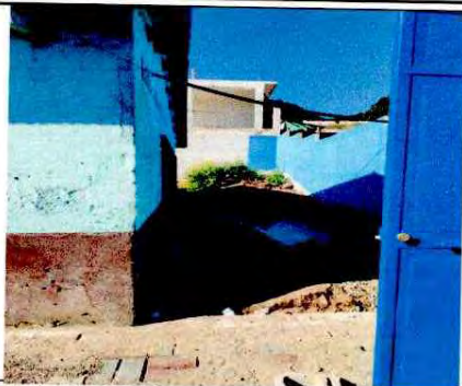
Foto 1: CUNETA DE CONCRETO
