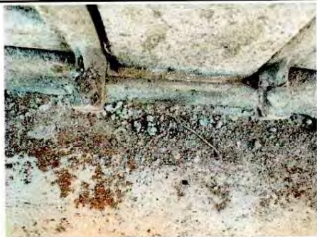
Foto 1: PUERTA EN ÁREA DE BAÑOS
