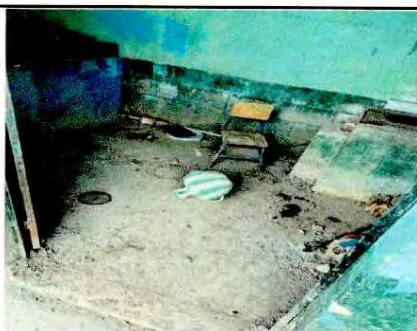
Foto 5: ÁREA INTERIOR DE COCINA
