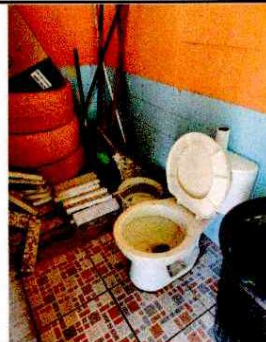
Foto 4: SUSTITUCIÓN DE SANITARIO COMPLETO (INCLUYE CONTRALLAVE)
