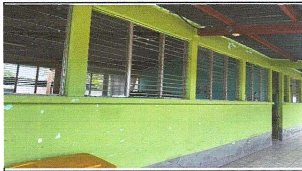
Foto 3: Pintura exterior de toda la escuela
