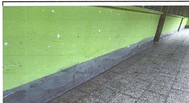
Foto 4: reparacion de repello y cernido
