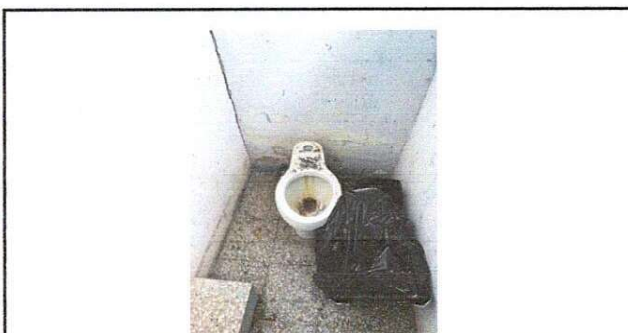
Foto 6: Sustitucion de baños
