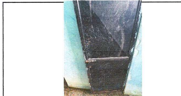
Foto 5: Mantenimiento a puertas de aulas y baños.
