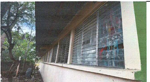
Foto 2: Instalacion de balcones y cambio de vidrios quebrados en toda la escuela.
