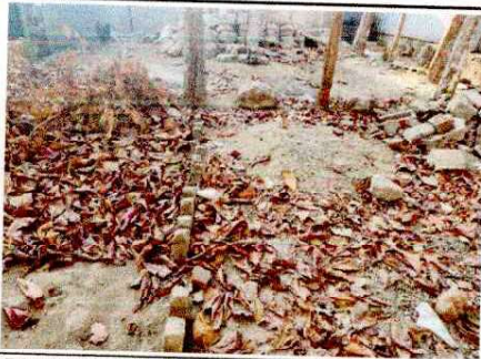
Foto 3: REPARACION PISO DE PATIO (ADOQUÍN)
