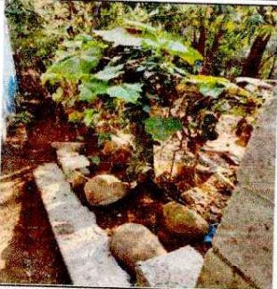
Foto 1: SUSTITUCIÓN DE CERCO PERIMETRAL CON BLOCK Y MALLA
