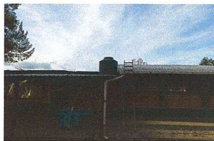
Foto 2: TANQUES Y DEPOSITOS DE AGUA
