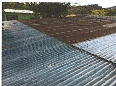
Foto 1: CUBIERTA DE LAMINA
