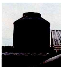
Foto 5: REPARACION DE SISTERNAS Y DEPOSITOS DE AGUA
