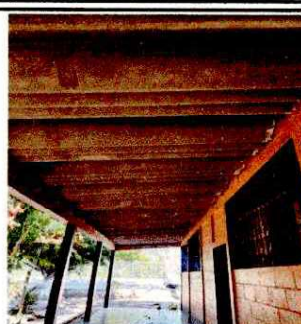
Foto 2: SUSTITUCIÓN ESTRUCTURA DE TECHO
