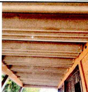
Foto 1: SUSTITUCIÓN LAMINA TROQUELADA CALIBRE 26
