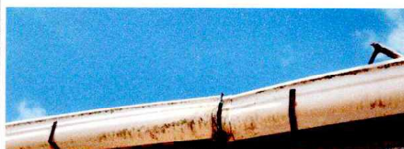
Foto 4: SUSTITUCIÓN DE CANALES Y BAJADAS 4"
