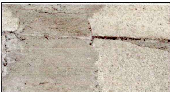
Foto 3: SUSTITUCIÓN DE REPELLO Y CERNIDO EN PAREDES.
