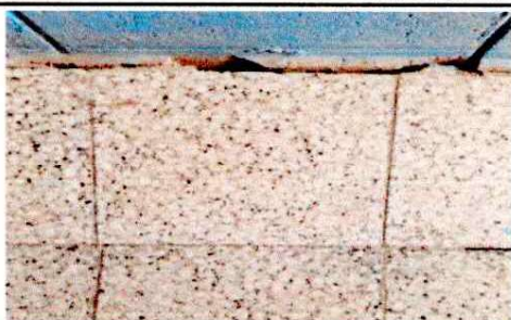
Foto 1: SUSTITUCIÓN PISO DE GRANITO (INCLUYE BASE CON MEZCLON).
