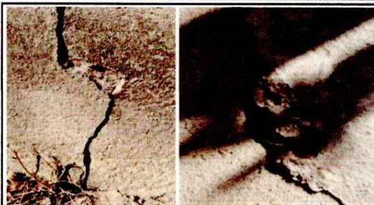
Foto 2: SUSTITUCIÓN LOSA DE PATIO (INCLUYE BASE, FUNDICIÓN Y ACABADO).
