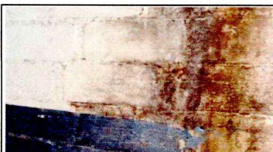
Foto 4: SUSTITUCIÓN DE PINTURA EN MUROS INTERIORES Y EXTERIORES.
