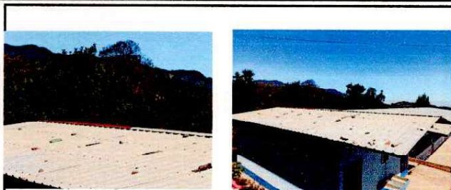
Foto 1: CUBIERTA DE LAMINA (CAMBIO DE 410 M2 DE LAMINA ANTIGUA POR LAMINA TROQUELADA CAL.26)
