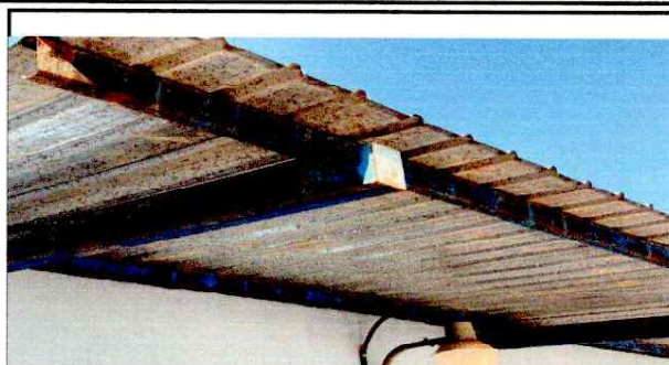
PINTAR 150 METROS LINEALES CON PINTURA DE TECHO CON PINTURA ANTICORROSICA
