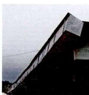
Foto 4: CANALES Y BAJADAS DE AGUA PLUVIAL
