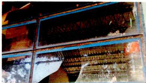
Foto 3: VENTANAS (SUSTITUCION DE 12 VENTANAS METALICAS CON VIDRIOS EN MAL ESTADO DE MEDIDAS 3.10 MTS. DE LARGO POR 62 CMS DE ALTO)
