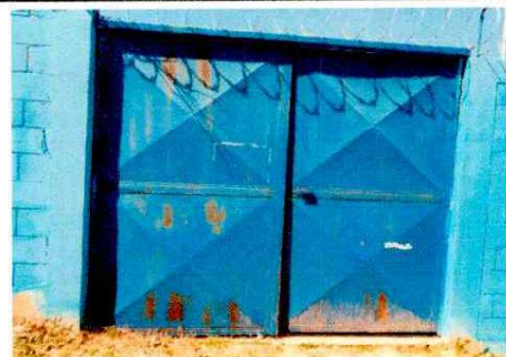
Foto 6: MANTENIMIENTO A PORTONES
