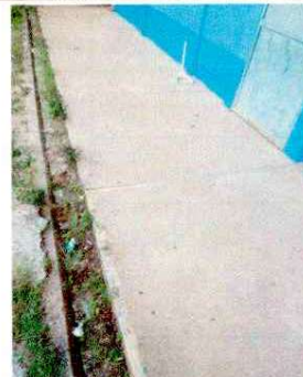
Foto 4: CUNETA DE CONCRETO
