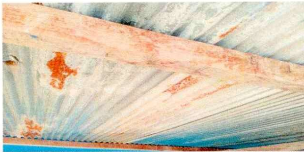
Foto 1: CUBIERTA DE TECHO
