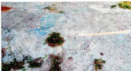
Foto 7: LOSA DE PATIO
