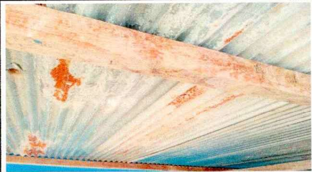
Foto 2: ESTRUCTURA DEL TECHO
