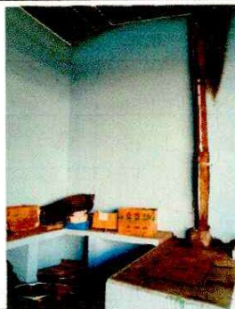
Foto 10: REPARACIÓN O SUSTITUCIÓN DE AREA DE COCINA
