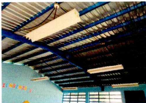
Foto 8: REPARACIÓN DEL SISTEMA ELECTRICO
