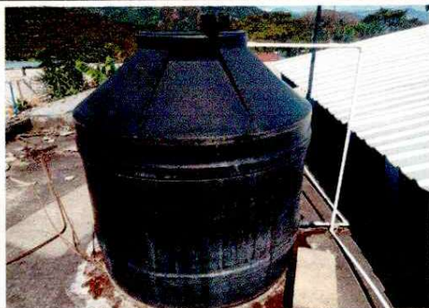
Foto 9: REPARACIÓN Y MANTENIMIENTO A DEPOSITO DE AGUA
