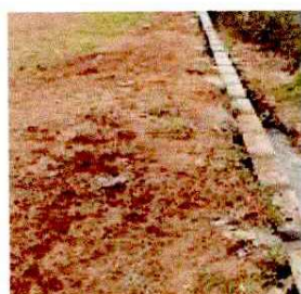
Foto 5: CERCO O MURO PERIMETRAL (TUBO GALVANIZADO Y MALLA)
