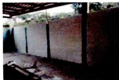
Foto 4: MURO PERIMETRAL (LEVANTADO CON BLOCK)
