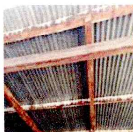
Foto 2: ESTRUCTURA DE TECHO
