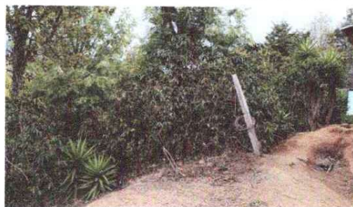
Foto 4: CERCO EN MAL ESTADO POR LA PARTE DE ATRÁS DE LA ESCUELA
