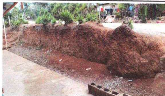
Foto 2: SE OBSERVA EL PAREDON QUE DIVIDE LA ESCUELA Y LA CALLE
