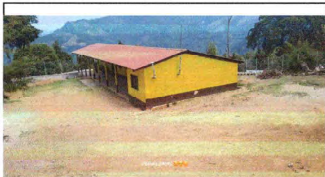
Foto3: Sustitucion de repello a pared y cernido a pared 300mts2
