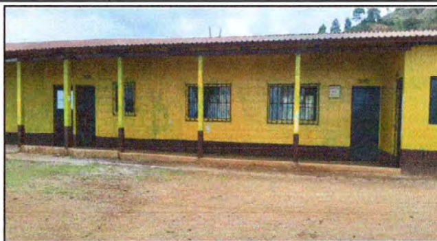
Foto 2: sustitucion de repello a pared de 300mts 2
