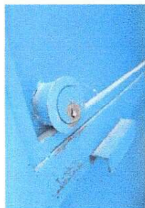
Foto2: Puerta de dirección y laboratorio se queda atorrada. Chapa de servicio sanitario de mujeres con defecto en doble llave.
