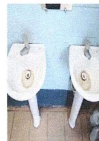
Foto 6: La parte de arriba de los lavamanos fue instalada erróneamente lo que hace que el agua se repose. Los accesorios de la parte de atrás de los lavamanos tiene fuga.
