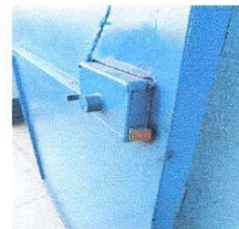
Foto2: Puerta de dirección y laboratorio se queda atorrada. Chapa de servicio sanitario de mujeres con defecto en doble llave.
