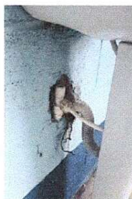
Foto 6: La parte de arriba de los lavamanos fue instalada erróneamente lo que hace que el agua se repose. Los accesorios de la parte de atrás de los lavamanos tiene fuga.
