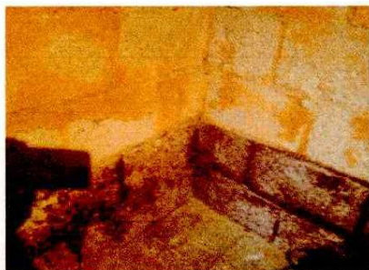
Foto1: reparacion de paredes de cocina
