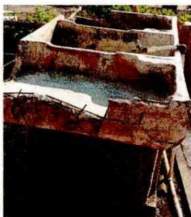
Foto 5: Sustitución de pila de concreto,
