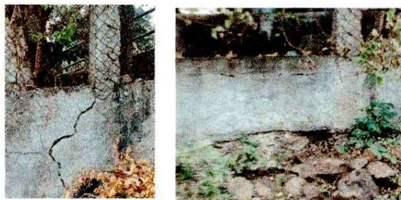
Foto 6: Reparación de nmuros de contención
