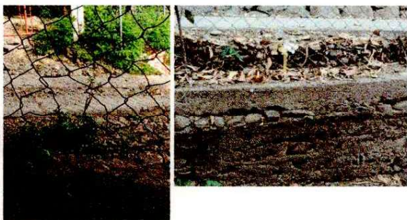
Foto 3: Reparación de muro perimetral
