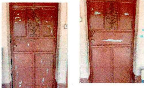
Foto1: Reparación de pintura en puertas
