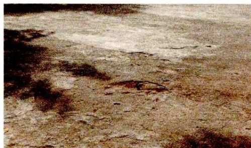
Foto 4: Reparación de losa de patio
