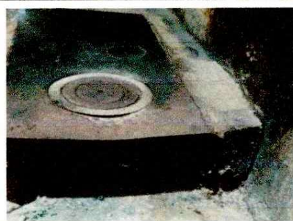
Foto 6: Reparacion de cocina
