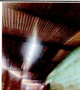
Foto 5: SUSTITUCIÓN LAMINA TROQUELADA CALIBRE 26
