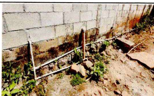
Foto 4: SUSTITUCIÓN DE RED DE AGUA POTABLE PVC 1/2" INCLUYE ACCESORIOS
