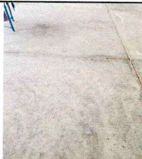
Foto 3: SUSTITUCIÓN PISO DE GRANITO (INCLUYE BASE CON MEZCLON)
