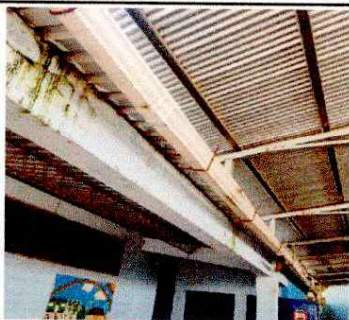
Foto 1: SUSTITUCIÓN DE CANALES Y BAJADAS 4"
