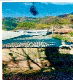
Foto 6: Sustrución de techo.
