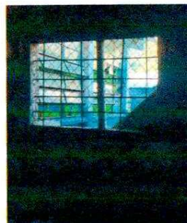
Foto 4: Sustrución de ventana.
