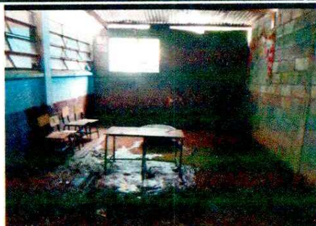
Foto 3: Restauración de Piso.
