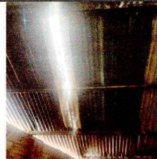
Foto 4: SUSTITUCIÓN LAMINA TROQUELADA CALIBRE 26
