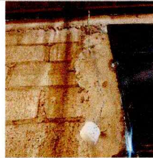
Foto 2: SUSTITUCION DE TOMACORRIENTE
