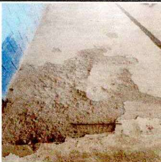
Foto 3: SUSTITUCIÓN LOSA DE PATIO INCLUY BASE, FUNDICION Y ACABADO
