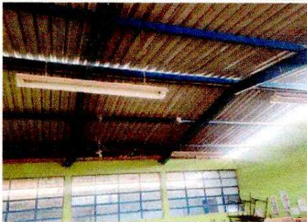
Foto1: SUSTITUCION DE LAMPARA LED INCLUYE INTERRUPTOR
