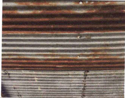
Foto 1: Cubierta de Lamina
