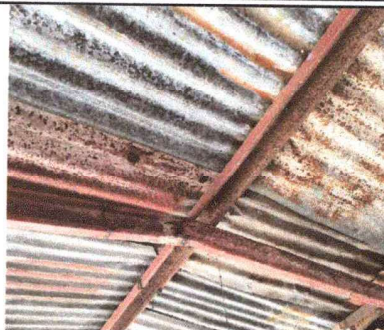
Foto 2: Estructura de techo
