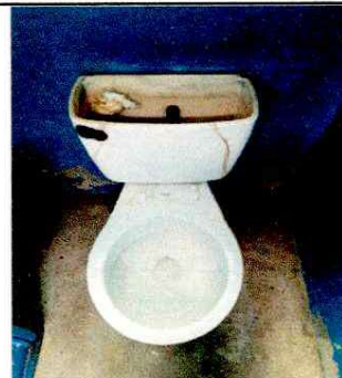
Foto 4: SUSTITUCION DE SANITARIO COMPLETO (INCLUYE CONTRALLAVE)
