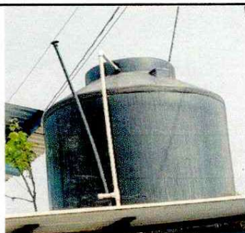
Foto 5: SUSTITUCION DE DEPOSITO DE AGUA (TIPO ROTOPLAS)
