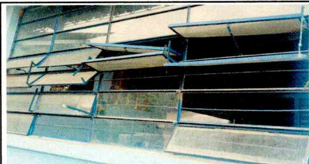
Foto 6: REPARACION Y MANTENIMIENTO DE VENTANAS PINTURA, CILICON, LIMPIEZA DE VIDRIOS
