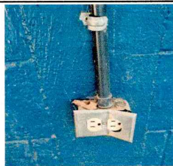
Foto 2: SUSTITUCION DE TOMACORRIENTE
