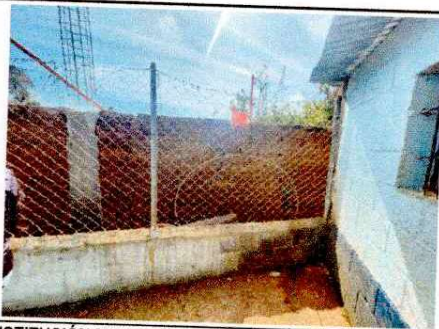
Foto 3: SUSTITUCION MURO PERIMETRAL BLOCK CISADO MAS COLUMNAS DE CONCRETO ESABIETADAS
