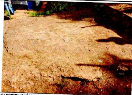
Foto 2: SUSTITUCION LOSA DE PATIO INCLUY BASE, FUNDICION Y ACABADO
