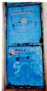
Foto 4: Las puertas se encuentran en mal estado, necesitan pintura y algunas cambio chapas y cambiar partes deterioradas por el óxido.
