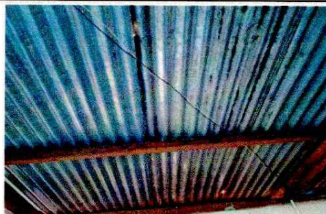
Foto 2: Actualmente el aula cuenta con cubierta de lámina acanalada la cual ya se encuentra en mal estado.
