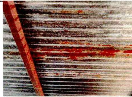
Foto 2: sustitucion estructura de techo
