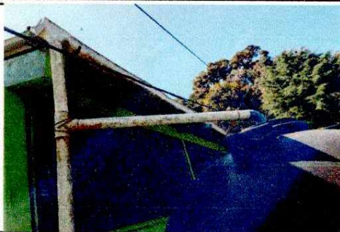
Foto 7: Reparación y mantenimiento de depósitos de agua
