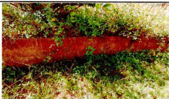
Foto 9: Sustitución de muro de block pineado incluye tubos de drenaje
