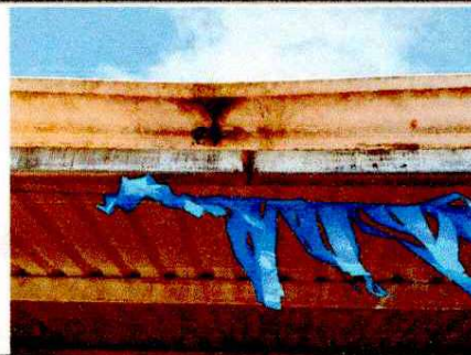
Foto 4: sustitución de canales y bajadas 4"
