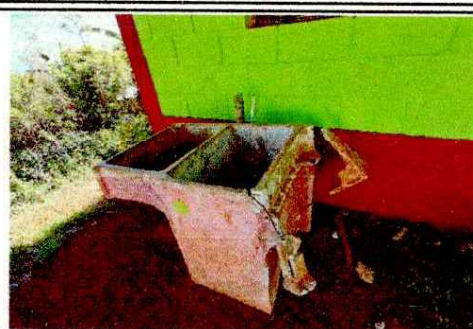
Foto 8: sustitución de pila
