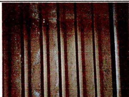
Foto 1: sustitución lamina troquelada calibre 26
