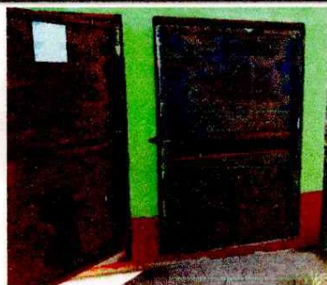
Foto 3: sustitucion de puertas en area de baño, reparación y mantenimiento de puertas en area de baños
