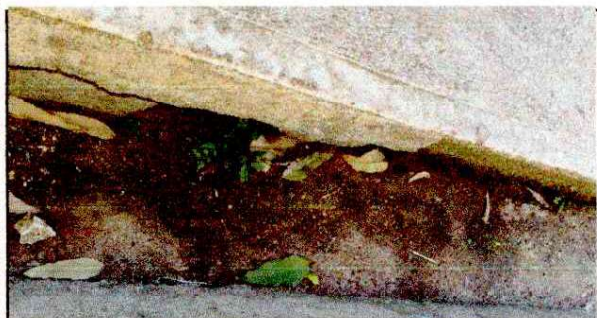
Foto 5: sustitucion de cuneta de concreto
