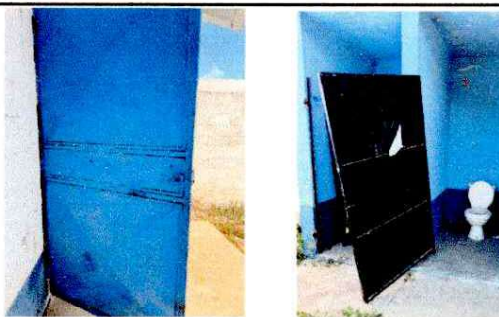
Foto 5: Reparación de puertas en Aulas y sustitución de puertas de los baños por estar en mal estado.
