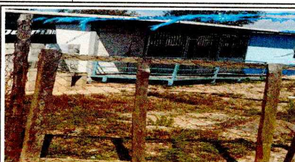
Foto 2: SUSTITUCIÓN DE PORTON CON MALLA Y TUBO
