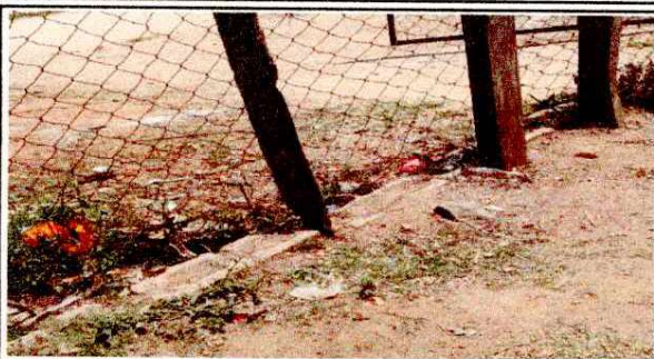
Foto 1: SUSTITUCIÓN DE CERCO PERIMETRAL CON TUBO GALVANIZADO Y MALLA 1/2 METROS DE ALTO
