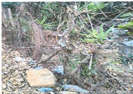
Foto 5: Estado de cerco actual
