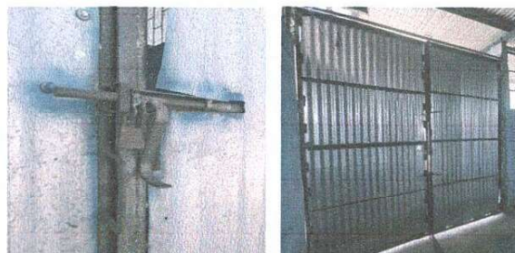
Foto 6: Sustitución de portón aula de mecánica
