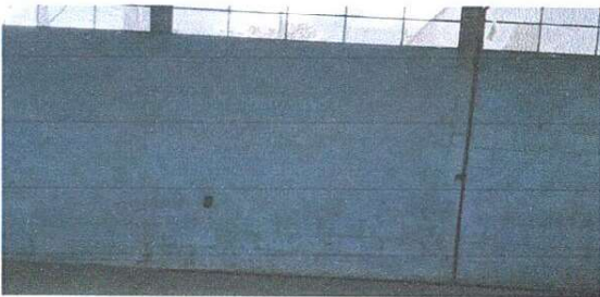
Foto 3: Cambio de pintura edificio escolar
