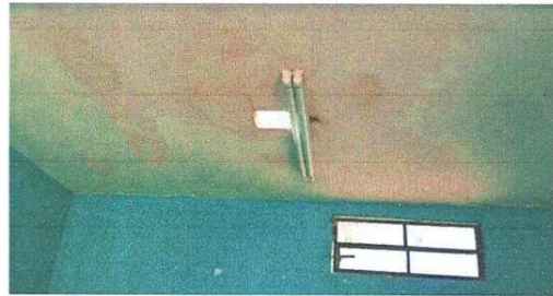
Foto 2: Impermeabilización de aulas
