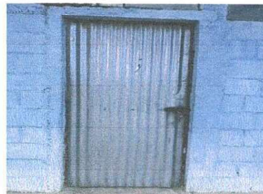
Foto 4: Sustitución de puertas de baños
