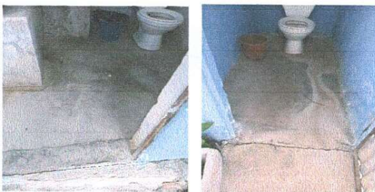
Foto 5: Sustitución de piso en los sanitarios
