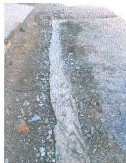
Foto 10: Reparación de cuneta agua llovediza
