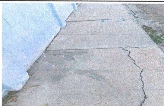
Foto 11: Reparación Banqueta de aulas
