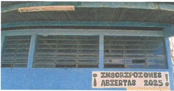
Foto 1: Reparación de vidrios
