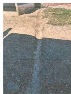
Foto 10: Reparación de cuneta agua llovediza
