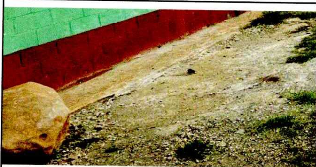
Foto 3: SUSTITUCION DE LOSA DE PATIO
