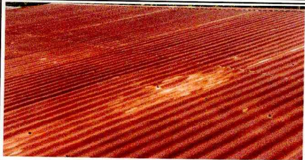
Foto1: SUSTITUCION DE 100 M2 DE LAMINA TROQUELADA CALIBRE 26.
