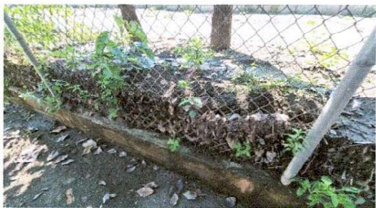
Foto 1: SUSTITUCIÓN DE CERCO PERIMETRAL CON BLOCK Y MALLA
