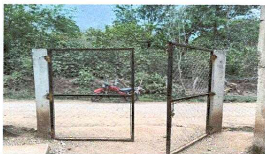
Foto 2: SUSTITUCION DE PORTON DE TUBO CON MALLA (PROMEDIO DE 3.5X2MTS)
