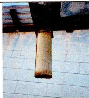
Foto 4: SUSTITUCIÓN DE CANALES Y BAJADAS 4"
