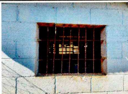
Foto 3: SUSTITUCIÓN DE VENTANAS (2 METROS DE LARGO X 1 METRO DE ALTO)
