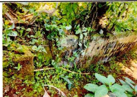
Foto 6: CERCO O MURO PERIMETRAL
