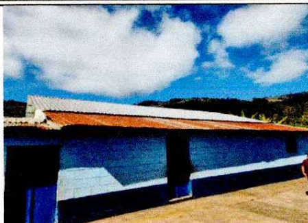
Foto 1: SUSTITUCIÓN LAMINA TROQUELADA CALIBRE 26
