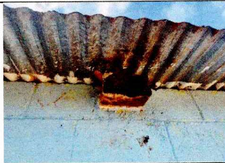
Foto 2: SUSTITUCIÓN ESTRUCTURA DE TECHO
