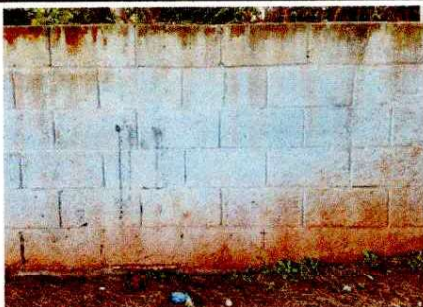
Foto 5: CERCO O MURO PERIMETRAL
