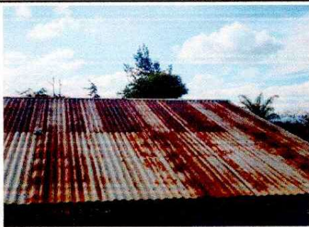
Foto1: SUSTITUCIÓN LAMINA TROQUELADA CALIBRE 26
