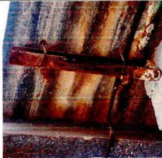
Foto 2: SUSTITUCIÓN ESTRUCTURA DE TECHO
