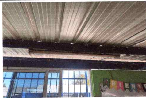
Foto 4: Reparación estructura de techo dañada con oxido por lluvias
