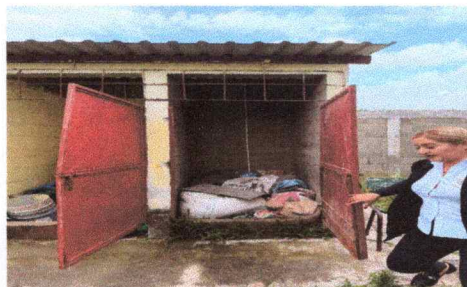
Foto 3: REPARACION DE SERVICIOS SANITARIOS
