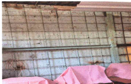
Foto 4: PINTURA EN MUROS INTERIORES
