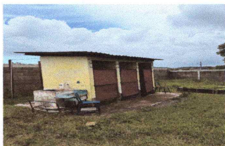
Foto 5: SUSTITUCION DE BANQUETA EN BATERIA DE BAÑOS
