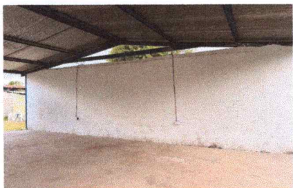
Foto 1: SUSTITUCION DE ENERGIA ELECTRICA EN GALERA
