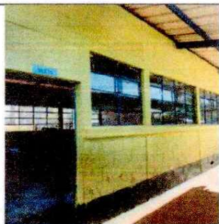
Foto 5: SUSTITUCIÓN PUERTAS EN AREA DE AULAS
