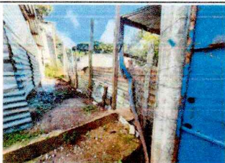
Foto 1: SUSTITUCIÓN MURO PERIMETRAL BLOCK CISADO MAS COLUMNAS DE CONCRETO ESABIETADAS
