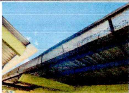
Foto 3: SUSTITUCIÓN DE CANALES Y BAJADAS 4"
