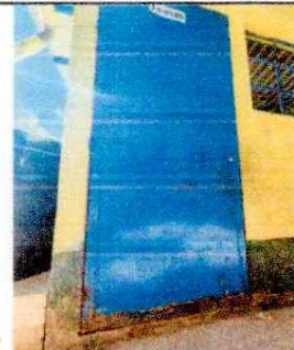
Foto 4: REPARACIÓN Y MANTENIMIENTO PUERTAS EN AREA DE AULAS
