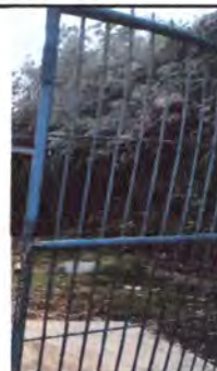
Foto 4: MANTENIMIENTO A PORTONES
