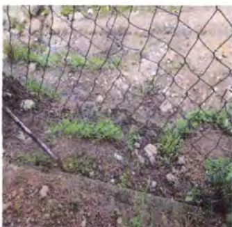
Foto 3: CERCO O MURO PERIMETRAL
