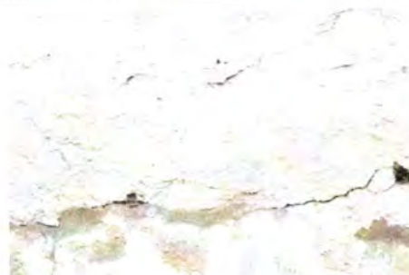
Foto 12: SUSTITUCION DE REPELLO Y CERNIDO (AREA DE BAÑO)
