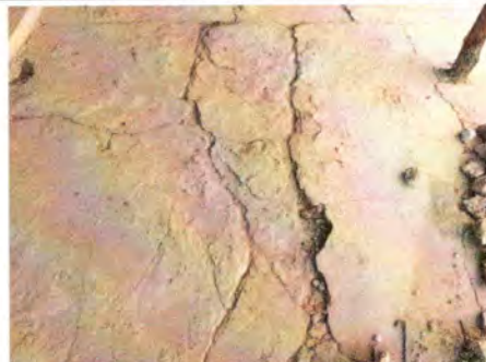
Foto 8: SUSTITUCIÓN LOSA DE PATIO (INCLUYE DEMOLICIÓN, BASE, FUNDICIÓN, ACABADO Y EXTRACCIÓN DE RIPIO)
