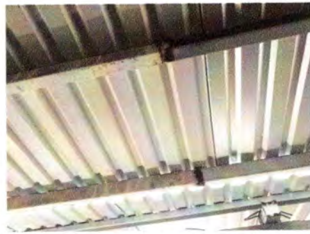
Foto 2: SUSTITUCIÓN ESTRUCTURA DE TECHO CON COSTANERAS METALICAS
