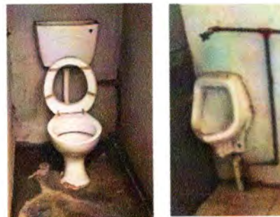
Foto 6: SUSTITUCIÓN DE SANITARIO COMPLETO (INCLUYE CONTRALLAVE) 6.2 SUSTITUCIÓN DE URINAL (PORCELANA)
