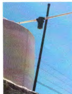
Foto 10: REPARACION Y MANTENIMIENTO DE DEPOSITO DE AGUA (ROTOPLAS)(INCLUYE KIT DE FILTRO)
