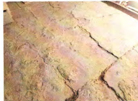
Foto 4: SUSTITUCIÓN PISO DE CEMENTO (DEMOLICIÓN, BASE, FUNDICIÓN MAS ACABADO) EN AREA DE CORREDOR Y BAÑO
