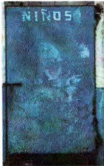
Foto 3: SUSTITUCIÓN PUERTA EN AREA DE BAÑO
