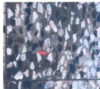
Foto 4: sustitución piso de granito.
