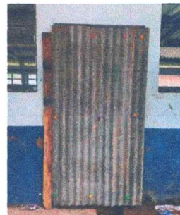
Foto 2: Sustitución de Puerta en Aula.
