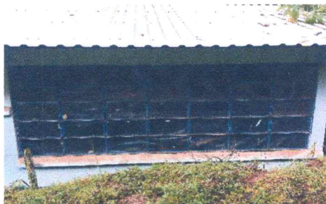
Foto1: Sustitución de ventanas en aulas.
