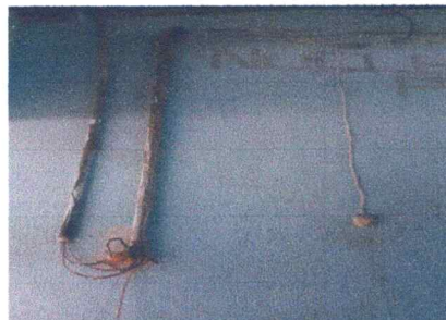
Foto 6: Reparación sistema eléctrico..
