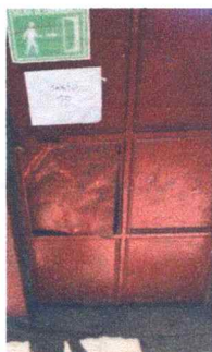
Foto 3: Reparación de puerta en aulas.
