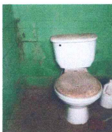
Foto 5: Sustitución de Baños.
