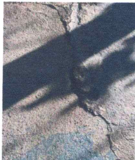
Foto1: Sustitución de Losa de patio.
