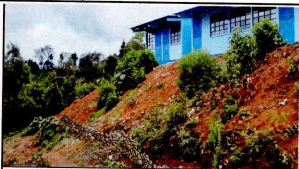
Foto1: SUSTITUCION MURO DE GAVIONES
