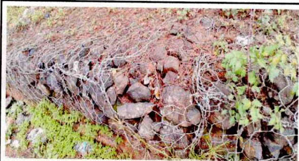
Foto 3: SUSTITUCION MURO DE GAVIONES
