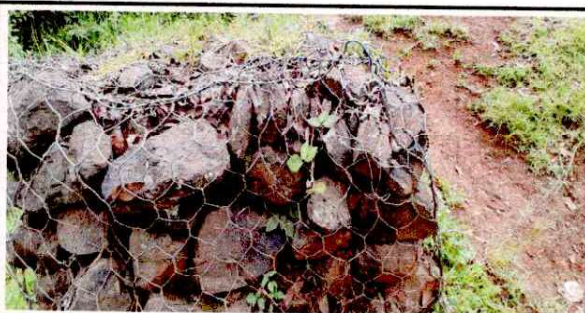
Foto 5: SUSTITUCION MURO DE GAVIONES
