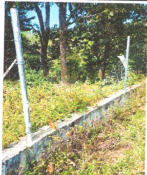
Foto 1: SUSTITUCIÓN DE CERCO PERIMETRAL CON BLOCK Y MALLA
