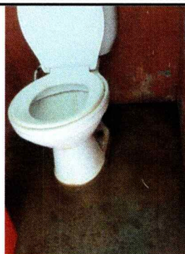
Foto 2: SUSTITUCIÓN DE ACCESORIOS INTERNOS Y TAPADAERA
